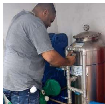
Limpeza do filtro central
