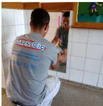
Instalação de novos espelhos
