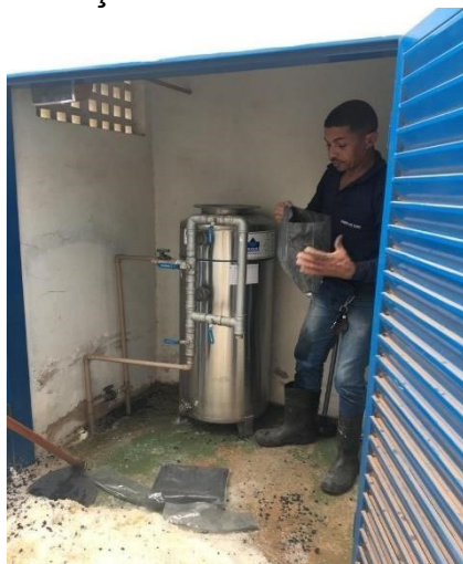
Manutenção do filtro central – Fotografia
