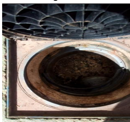
Foto 9 – Limpeza da caixa de gordura
