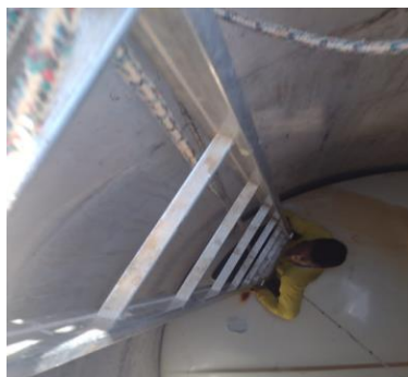
Foto 8 – Limpeza da caixa d'água
