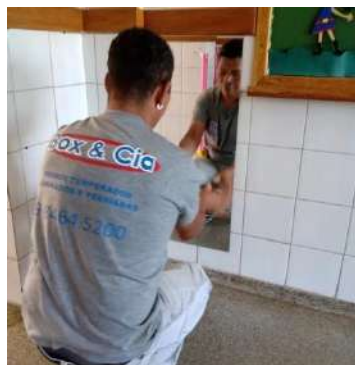
Instalação de novos espelhos
