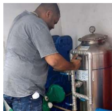
Limpeza do filtro central
