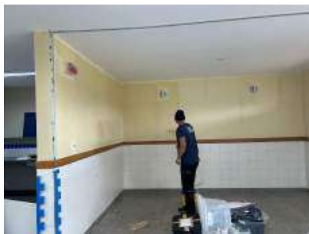
Pintura nos espaços da creche
