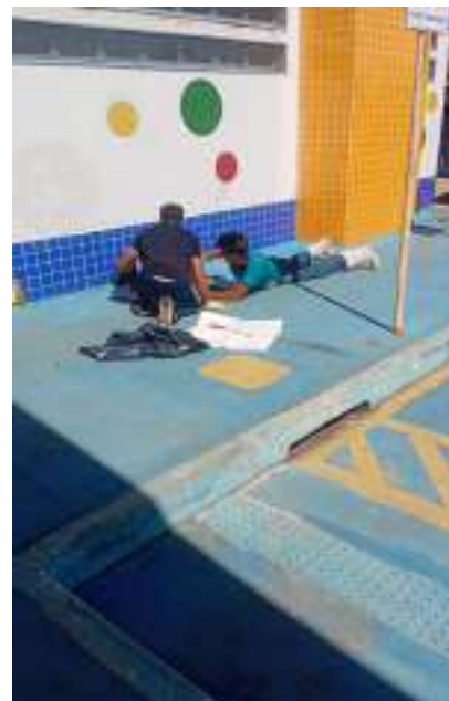
Limpeza das caixas de gordura
